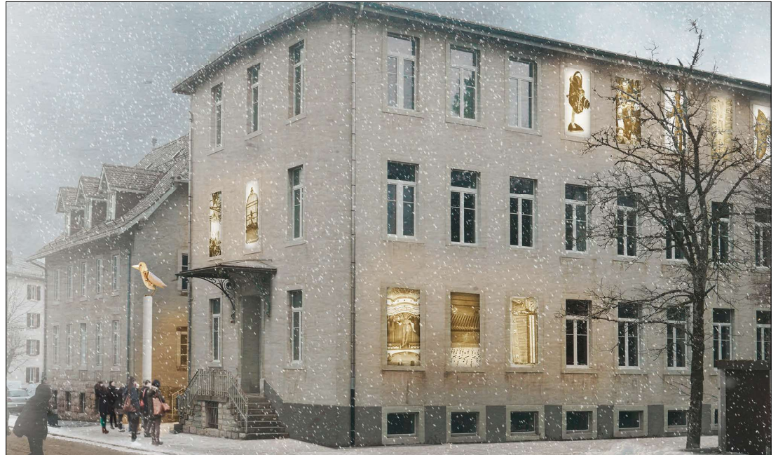
La transformation du bâtiment abritant le CIMA en vue d'accueillir le futur musée unique est actuellement à l'étape de la mise à l'enquête. Le financement du projet devrait être bouclé d'ici fin 2020.
